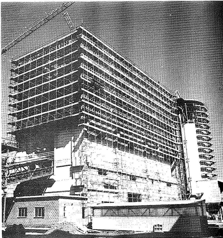
Fig. 19. Il capannone industriale della Cementeria di Barletta (Gruppo UNICEM) ha dimensioni planimetriche circa  $40 \times 17$  m con un'altezza di 35 m di cui la parte superiore, alta circa 17 m è interamente rivestita in mattoni d'acciaio con funzione di contrasto scatolare antisismico. Questi elementi assemblati in pannelli nello stabilimento di produzione di Napoli sono stati autotrasportati in cantiere e quindi sollevati e sigillati in opera.
